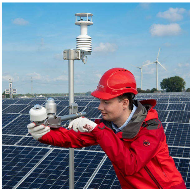
Rysunek 2 Typowe zastosowanie pyranometrów w elektrowniach fotowoltaicznych. Na ilustracji przedstawiono dwa pyranometry SR200-D1: jeden pochylony do pomiaru promieniowania w płaszczyźnie modułów (POA), drugi zamontowany poziomo do pomiaru globalnego promieniowania poziomego (GHI).
