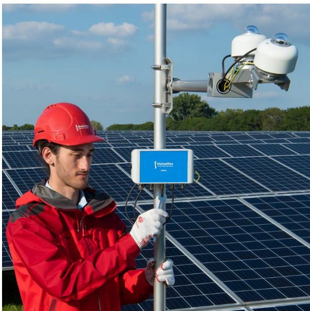
Rysunek 1 Ochrona przeciwprzepięciowa podniesiona do poziomu 4. Jedno Urządzenie ochrony przeciwprzepięciowej SPD01 może chronić do 3 pyranometrów.
